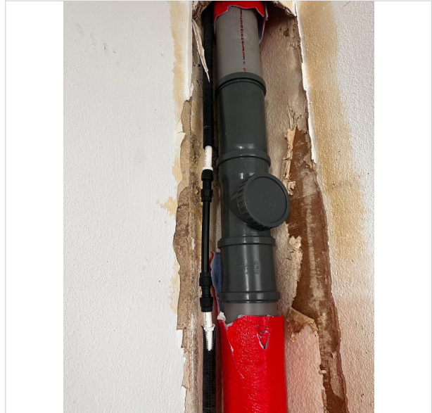
Abb. 14: Leitungsbereich nach Instandsetzung: Abwasserleitung mit eingebauter Putzöffnung (Revisionsöffnung); links Trinkwasserleitung mit neuen Verschraubungen.
