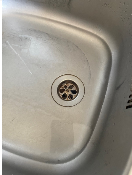
Abb. 2: Spülbecken Küche: Ablauf der überprüften Abflussleitung.
